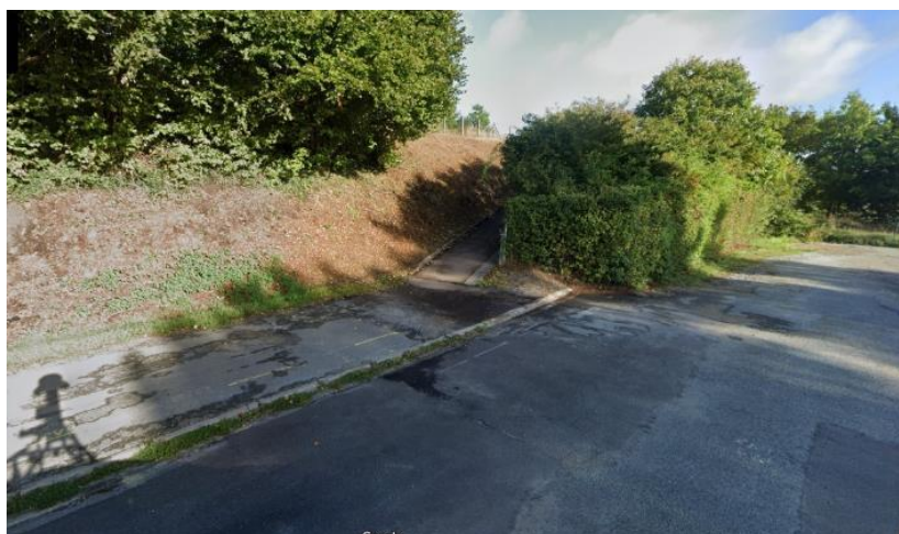
FIGURE 49 PASSERELLE AU-DESSUS DE LA RN145
