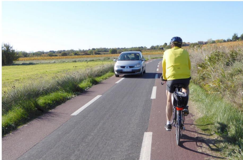
FIGURE 58 EXEMPLE DE CVCB
